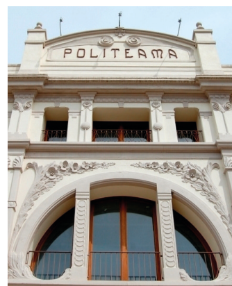
Teatro Politeama (1913) dettaglio della finestra terminale e della decorazione in facciata portati all’originaria bellezza dopo il restauro.
