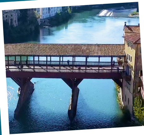
Restauro del Ponte degli Alpini
